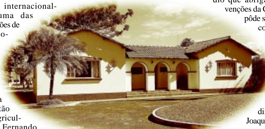
Sede da Estação Experimental de Limeira, construída na década de 40.
