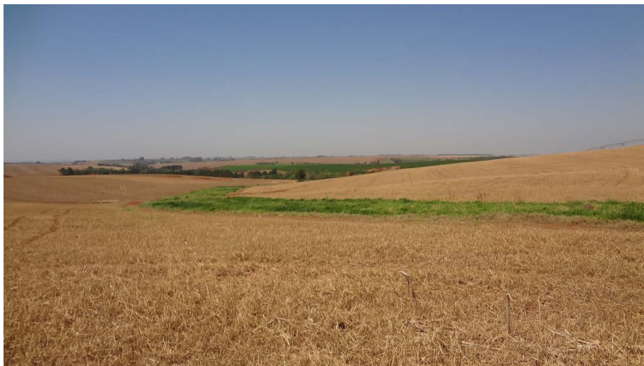
Figura 24. Canal escoadouro vegetado em projeto de controle da erosão com terraços de drenagem. Foto: Mario Ivo Drugowich, CATI.
