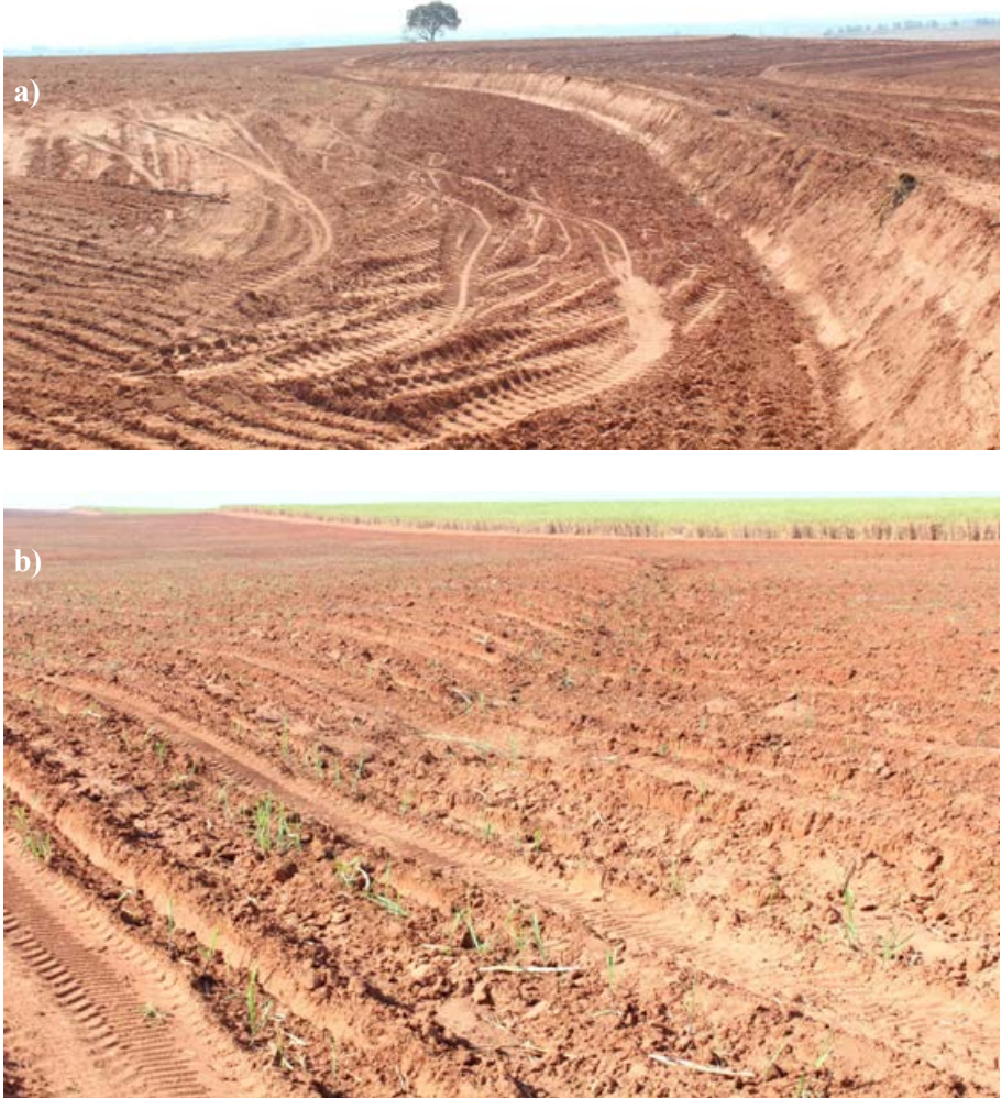
Figura 23. Seções de terraços em nível em solos com boa capacidade de infiltração de água: (a) maiores que 6 m 2 em Argissolo profundo, região de Dracena, SP e (b) menores que 1 m 2 , em Latossolo, região de Andradina, SP. Foto: José Osmar Bortoletti.
